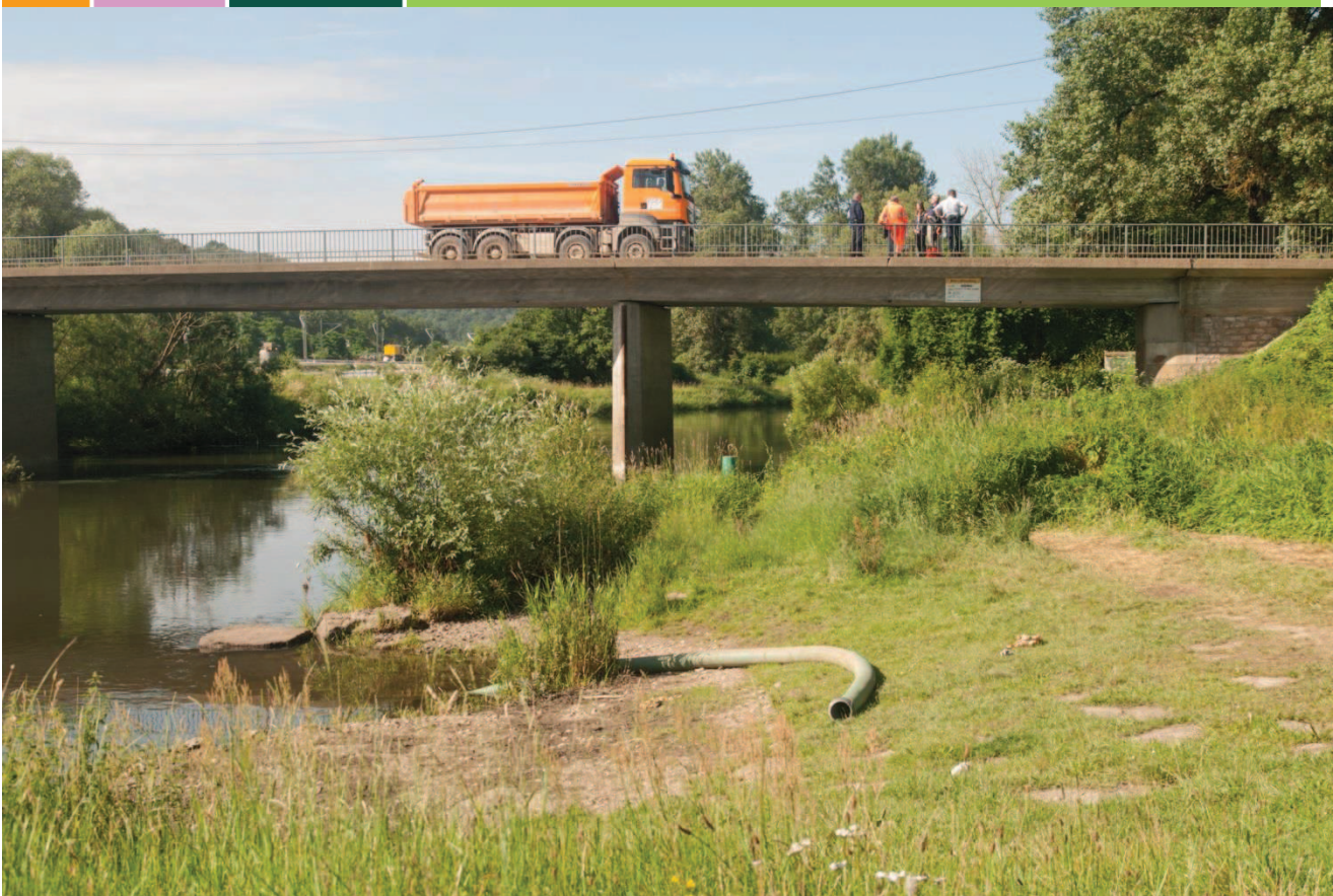
Noch steht die Straßenbrücke bei Ebing. Im August wird sie abgerissen. Foto: Flussparadies Franken
